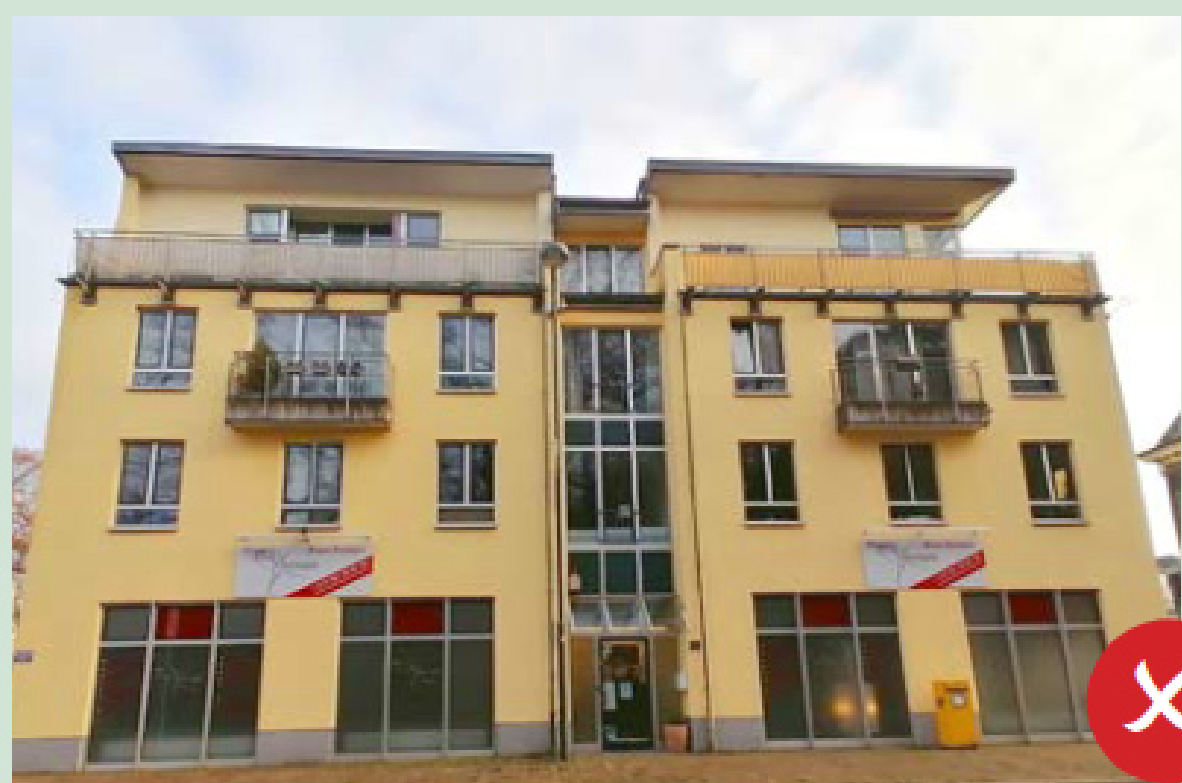
Gebäudefassade mit nicht abgetönter, greller Farbe
